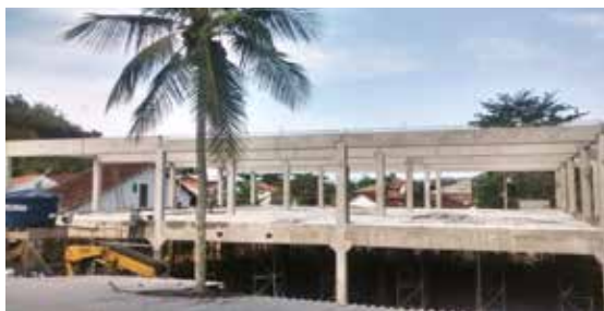
Hospital antes e depois da reforma
